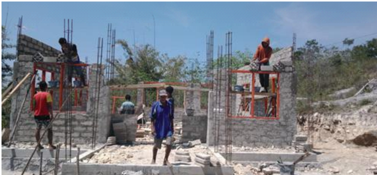
Gambar 4. Pembangunan PAUD sebagai salah satu kegiatan PKTD di Desa Makamenggiti, Kecamatan Nggaha Ori Angu, Kabupaten Sumba Timur
